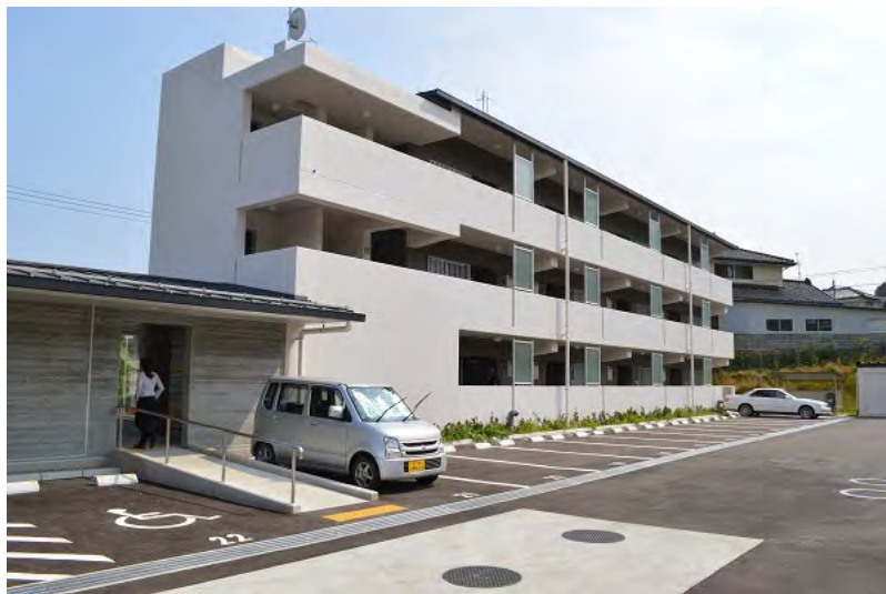
【集合タイプの災害公営住宅(大船渡市)】
