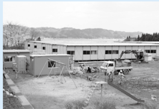
赤前小学校グラウンド内の仮設住宅
