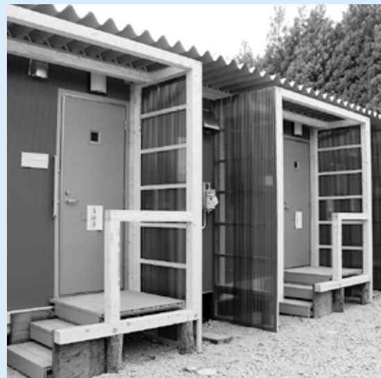
清寿荘隣接県有地内の仮設住宅
